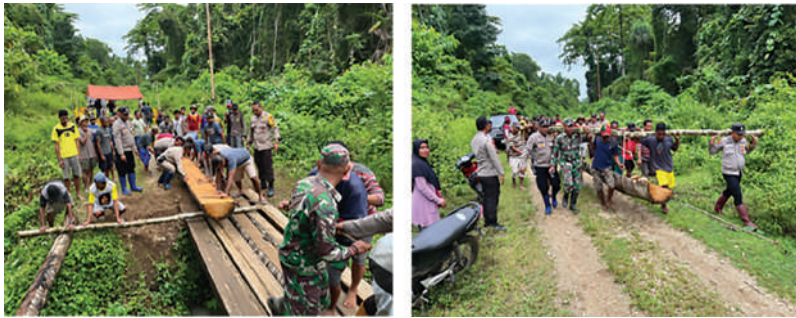
Gambar Gotong Royong Masyarakat Rangka Membangun Jembatan Penghubung
