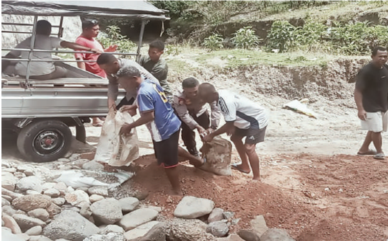
Gambar Linmas Desa Ona, Kabau dan Nahi Kecamatan Sulabesi Barat bersama Masyarakat Kerja bakti Perbaikan Jalan Utama Lintas Kota Sanana yang Rusak Karena Banjir
