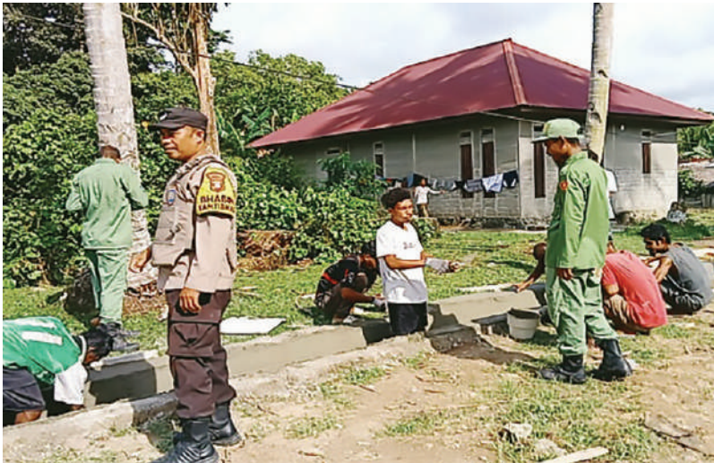
Gambar Kerjasama Pembangunan Saluran Air di Desa Ona Kecamatan Sulabesi Barat
